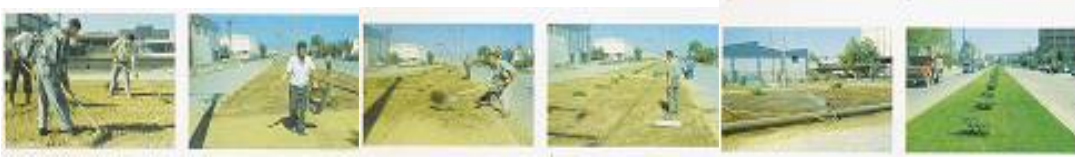
Fotoğraf 2.5: Toprağın ince tesviyesinden çim alanının oluşumuna kadar geçen evreler
