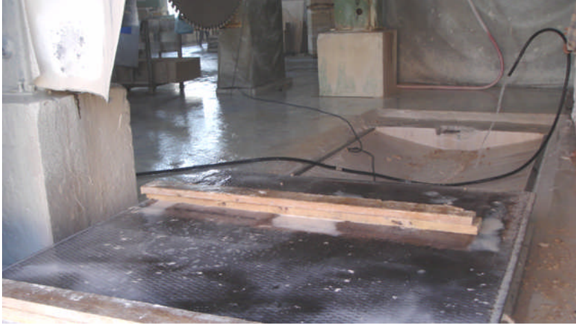
Resim 1.3: Vagonun temizlenmesi ve takozların yerleştirilmesi
