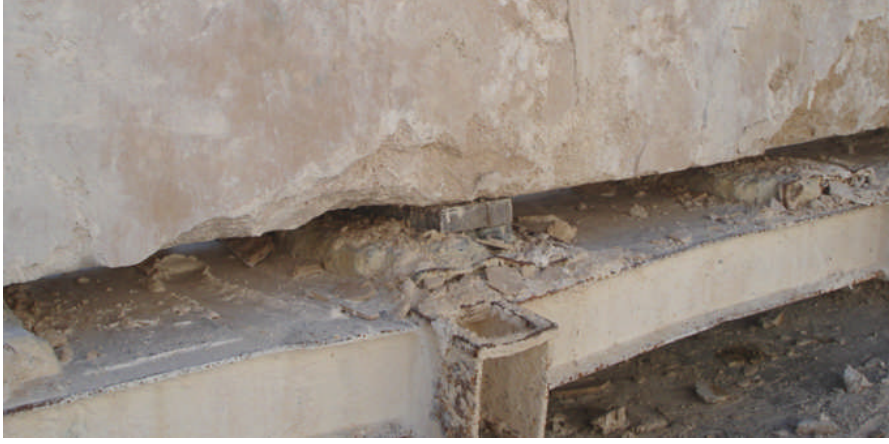
Resim 1.4: Vagonuna blok yerleştirilmesi ve boşluğun takozla desteklenmesi
