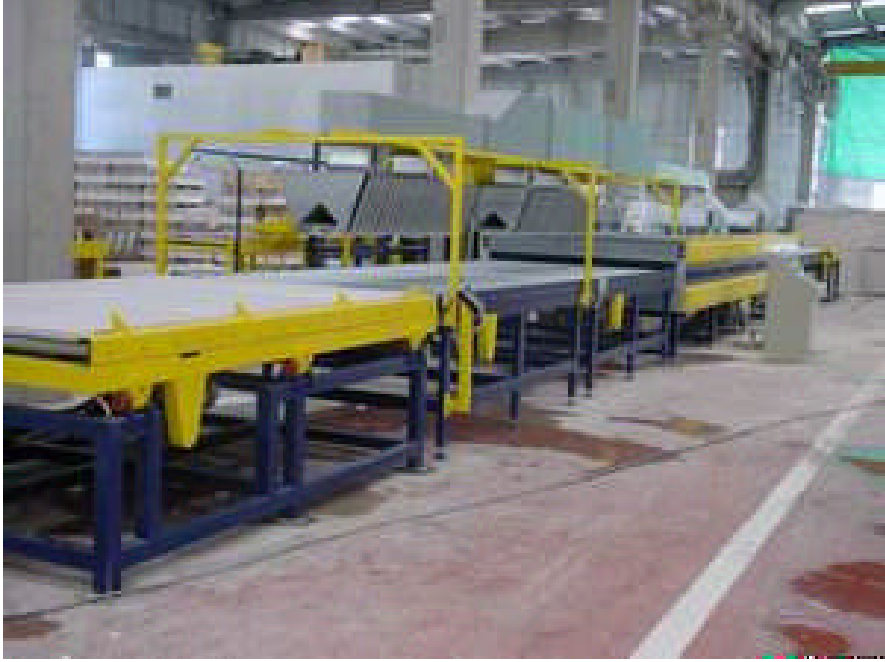
Resim 2.5: Plaka çatlak tamir/dolgu hattı
