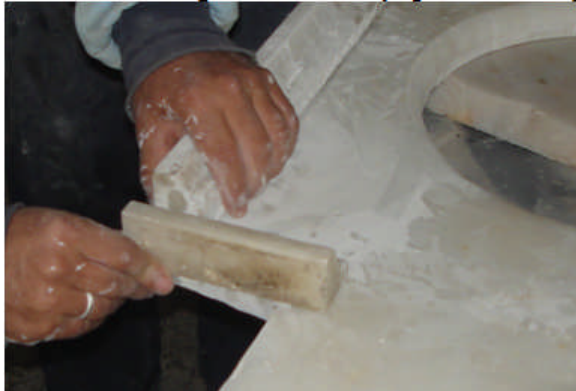
Resim 2.5. Mutfak tezgâhının çitalarının yapıştırılması
