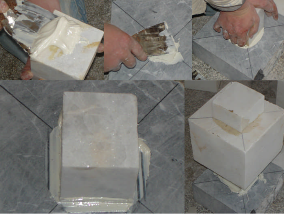
Resim 2.4: Takozun akemi ile yapıştırılması
