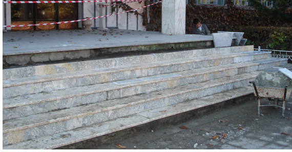
Resim 2.6: Doğal yapıştırıcılarla yapıştırma
