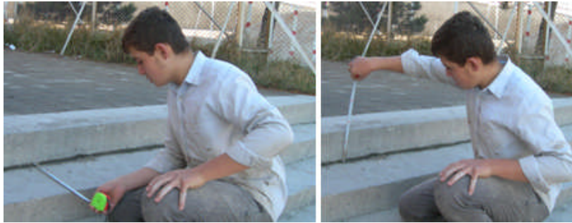
Resim 1.10:Basar ve rıht ölçülerinin alınması
