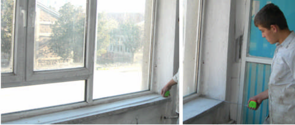
Resim 1.13: Denizlik ölçüsünün alınması
