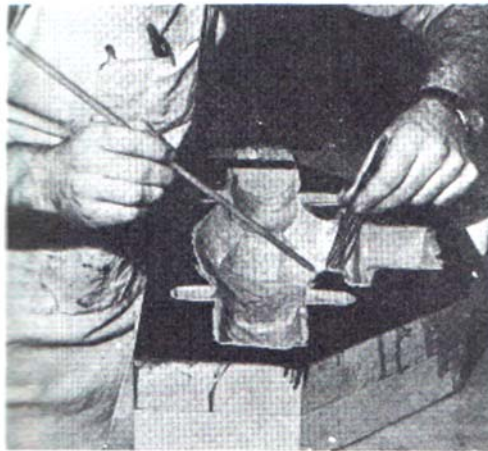
Resim 2. 10: Cam elyaf uygulaması
