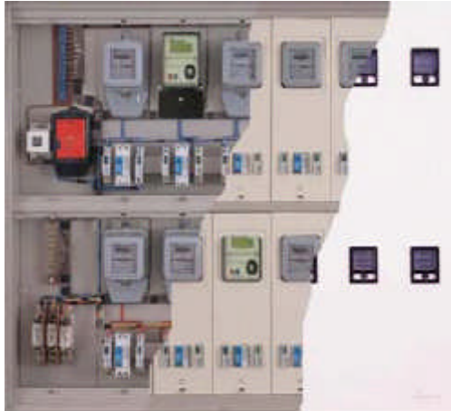
Resim 2.2: Bir apartmanın bir fazlı dağıtım panosu
