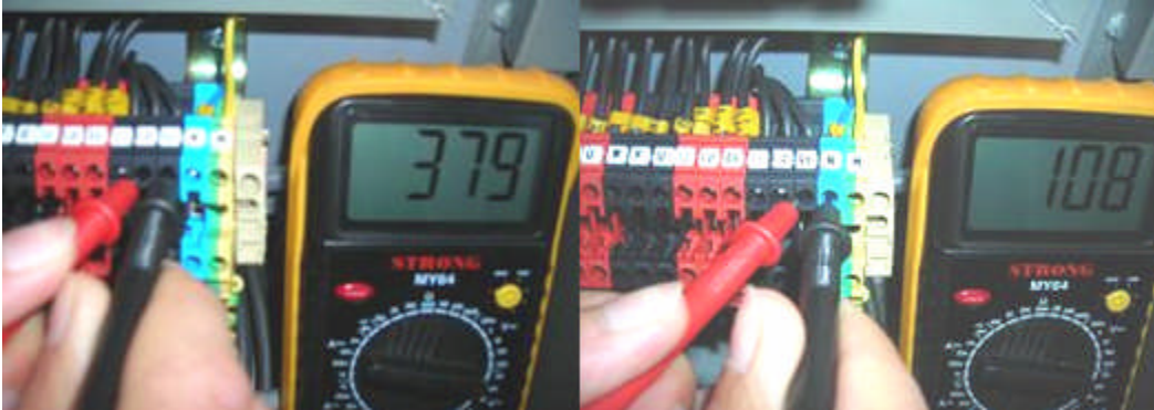
Resim 2.13: Pano giriş klemenslerinde faz-faz ve faz-nötr gerilim ölçümleri
