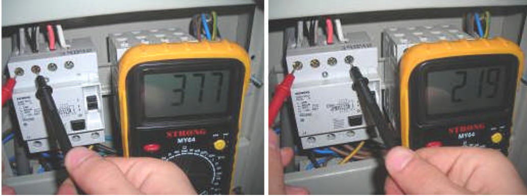
Resim 2.14: Ana şalter girişinden faz-faz ve faz-nötr gerilimlerinin ölçülmesi
