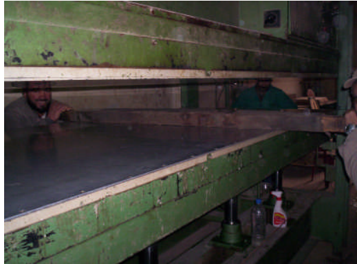
Resim 2. 3: Pres tablasının temizlenmesi
