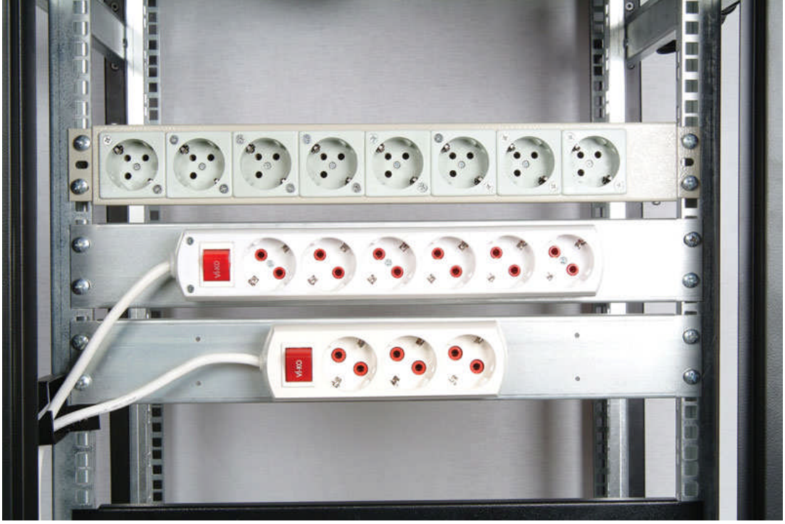
Resim 1.29: Kabin priz gruplarının kabin içindeki görünümü.
